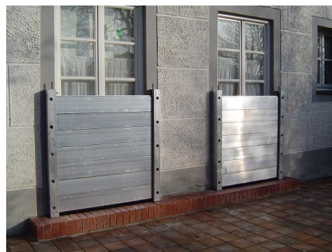
Figure 9 : Exemple de batardeaux
