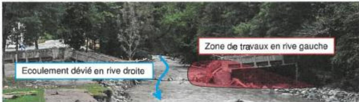
Afin de pouvoir évacuer les éléments béton de la rive gauche le plus rapidement possible, la pelle à chenille réduira le morceau de tablier et la pile, en blocs assez grossiers. Ces gros éléments de démolition seront chargés dans un tombereau et déposés sur la berge en rive droite. Ils seront ensuite démolis au BRH et à la cisaille béton.
