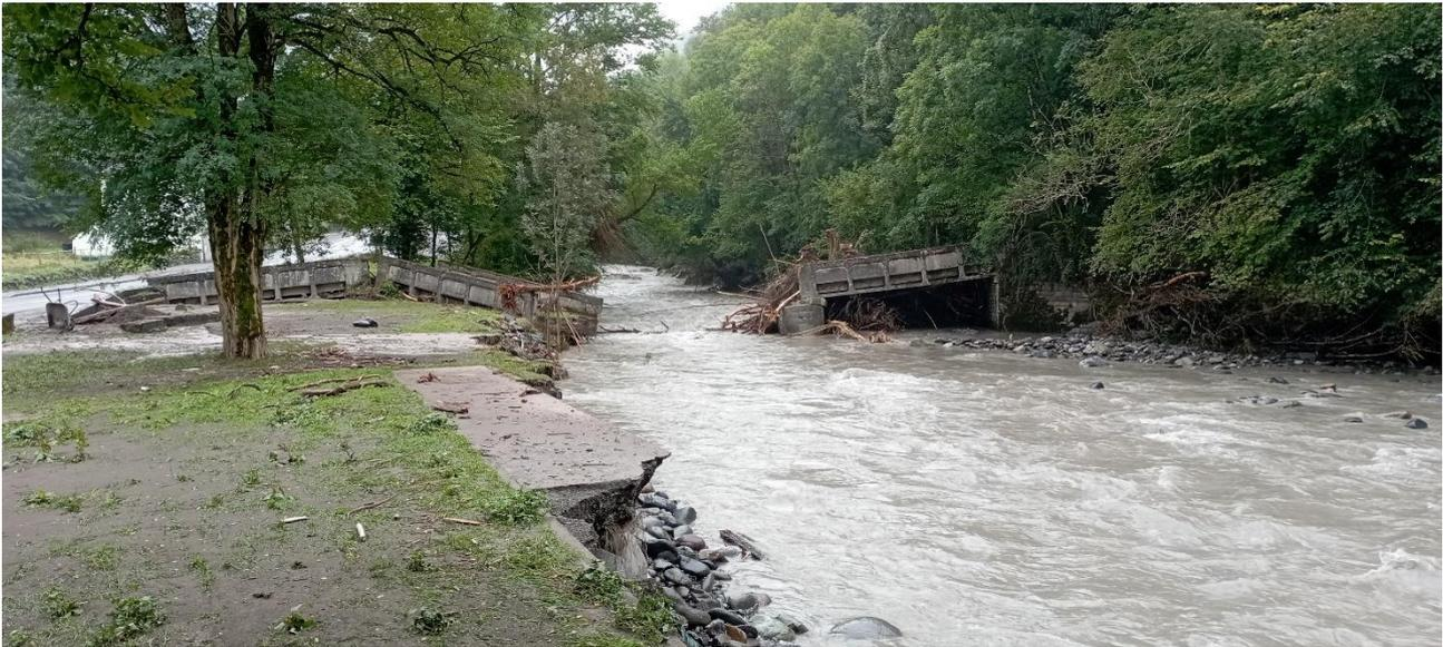
*Figure 1 : Pont d'Eygun (Pont de la Bigue) partiellement détruit par la crue avant travaux*
