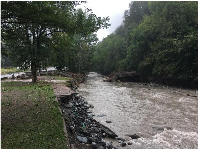
Figure 3 : Erosion de berge et pont effondré
