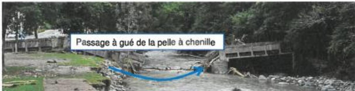
Ensuite elle réalisera un petit batardeau afin de bien canaliser l'écoulement en rive droite le temps de réaliser les démolitions sur place.
