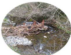
Encombrement de pièges à embâcles
